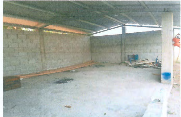
Foto 4: Mejoramiento de losa de piso.
